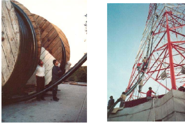
Fig. 9.24. Montaje de una línea de transmisión de 6.5”.
