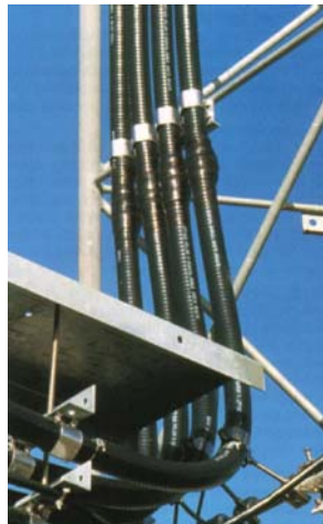
Fig. 9.26. Curvatura en líneas semiflexibles.
