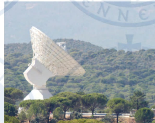
Medio no guiado: estación terrestre (diámetro: 35m) de seguimiento de satélites de Cebreros (Ávila, España) perteneciente a la Agencia Europea del Espacio (ESA)
